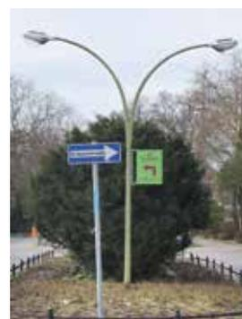
Abb. links: Seltener Doppelarm-Ausleger mit Gas-Reihenleuchten am Bahnhofsvorplatz Lichterfelde Ost. Foto (Ausschnitt)/Copyright: Philipp Bernstorff, Kiezmagazin Ferdinandmarkt
