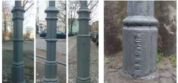
**Abb. links:** Originaler Bündelpfeilmast, gasbetrieben; b): neuer Bündelpfeilmast mit eingeschnittener Mastklappe durch BRAUN Lighting Solutions e. K.; c) neuer Bündelpfeilmast für Elektrobetrieb. b) und c) im Maßnahmengebiet in Berlin-Neukölln. Montage/Fotos/Copyright: Sabine Röck, Berlin
