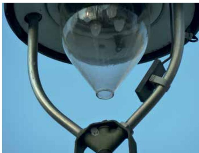
*Abb.: BAMAG U7 mit solarbetriebenen Dämmerungsschalter. Foto: Sabine Röck, Berlin*
