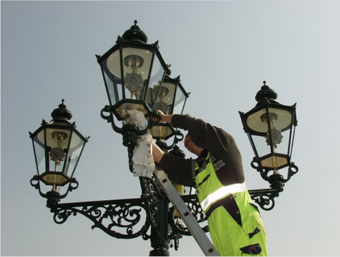
Instandsetzung und Pflege eines fünfarmigen Kandelabers[/caption]
