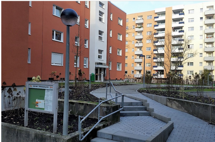
Vor der Umrüstung: Veraltete Kugelleuchte mit HQL-Leuchtmittel, unansehnlich und mit hohem Verbrauch
